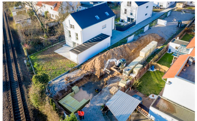
Rockflow Rigole unter Anliegerstraße
