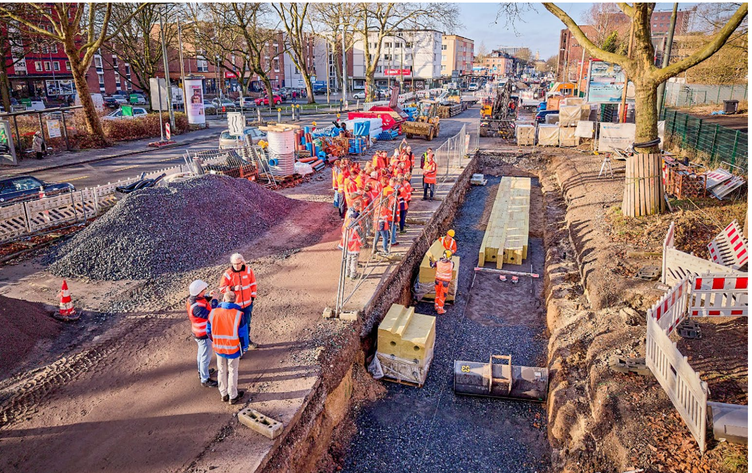
Einbau der Rockflow Rigole auf der Alleestraße in Bochum. Foto: Stadt Bochum.
