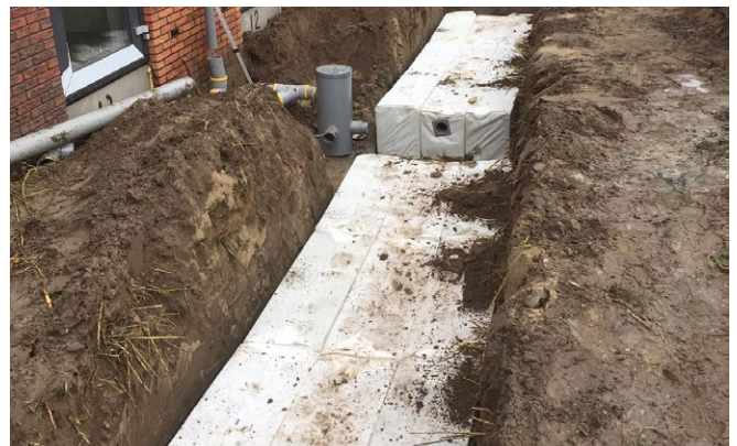
Praxisbeispiel Hydrorock Abkoppelkit im Reihenhausbau
