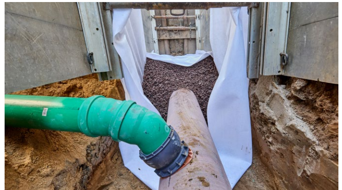
Praxisbeispiel Leichlingen: Duktile Gussrohre werden im Leitungsgraben in Skeletterde gebettet. Dieses gut durchlüftete Substrat dient den Bäumen als erweiterter Wurzelraum
