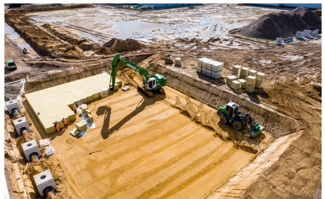
Rockflow Rigole unter einem Parkplatz
