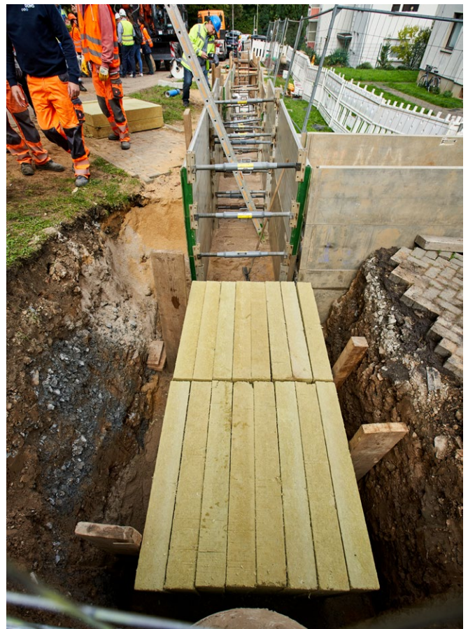
Praxisbeispiel Leichlingen: Rockflow wird über der Skeletterde im Leitungsgraben eingebaut. Gespeichertes Wasser versickert und wird so den Baumwurzeln im Leitungsgraben zur Verfügung gestellt
