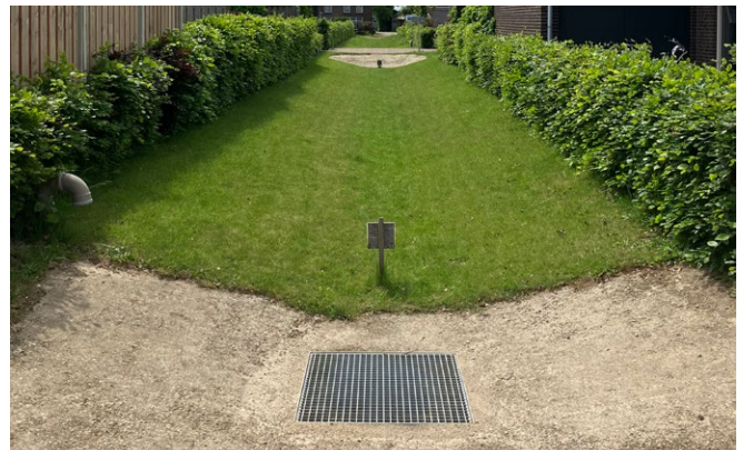
Praxisbeispiel einer fertiggestellten Rockflow Muldenrigole
