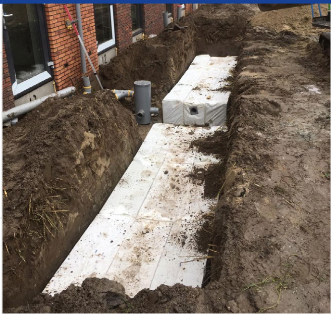
Voorbeeld van een Hydrorock afkoppelkit in de achtertuin van een woning
