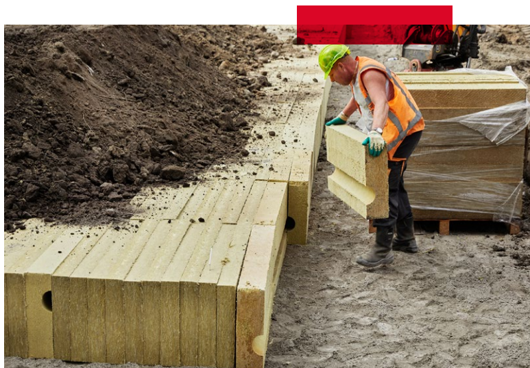
Met de hand installeren van Rockflowelementen van 50 cm hoog.
