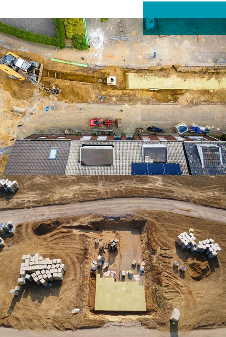
Rockflow aangelegd als lijnbuffer (boven) of centrale buffer (onder).
