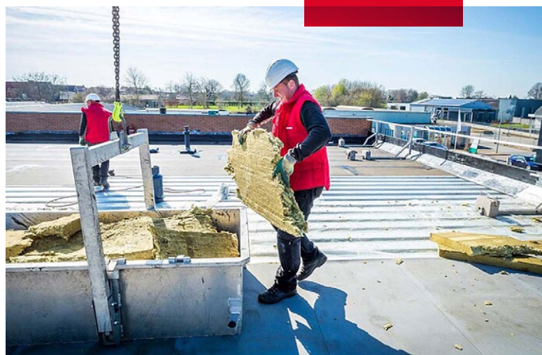
Steenwol verzamelen tijdens een verbouwing om gerecycled te worden.
