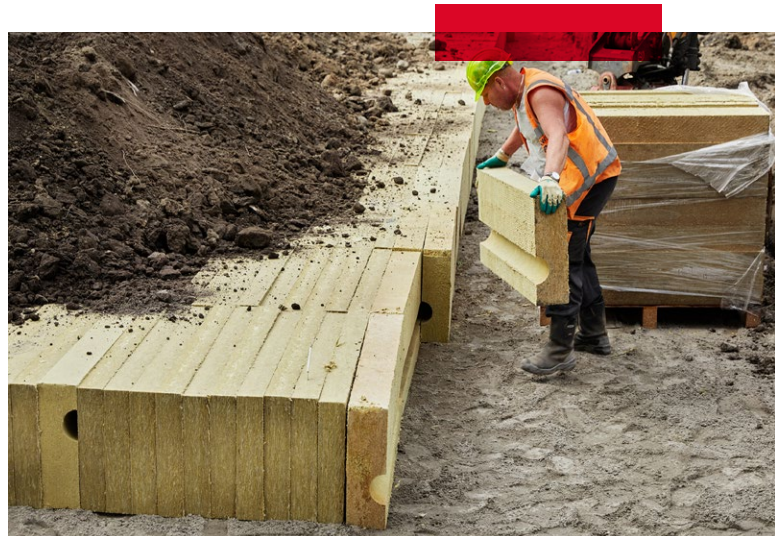
Manuelle Installation von 50 cm hohen Rockflow-Elementen
