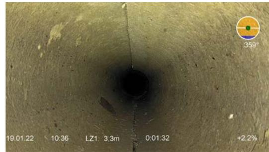
Abb. 6: Beispiel für einen sauberen Kanal (nach erfolgter Reinigung)
