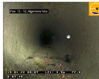
Abb. 7: Beispiel für eine typische Sedimentschicht von unter 2 cm
