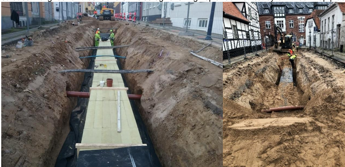
Figur 29: Regnvandshåndtering af vej- og tagvand under vej. Tv. Regnvandsledning udført i Rockflow elementer, der yder passiv forsinkelse og rensning af overfladevandet. Bemærk de krydsende kabler igennem magasinet. TH. den indpakkede "ledning" (bassin) under vej.
