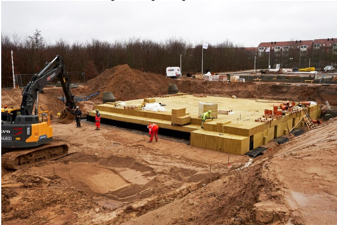
Figur 26: Etablering af forsinkelse og rensebassin Januar 2022. Indløb via til rækker af plastkassetter, med inspektions- og renseadgang.
