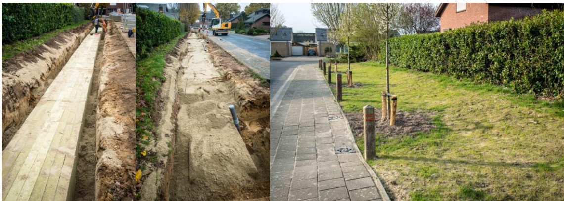
Figur 31: TV: Rockflow elementerne blev anlagt som et aflangt bassin, da det passede med området. Bassinet afvander ved nedsivning. MIDT: Efter elementerne var sat, blev der fyldt og komprimeret grus rundt om og over anlægget. Afslutningsvis blev der sået græs og sat træer.
