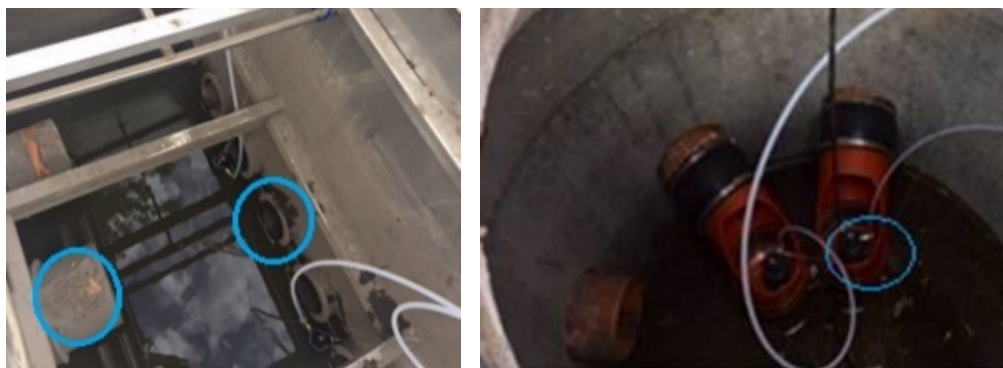
Prøver til måling af partikelstørrelsesfordeling. Tv. markering af indløbsrør til manifold og tilgangsrør til filteret, hvor sedimentet udtages. Th. rørføring til udløbsbrønd, hvor der udtages vandprøver.
