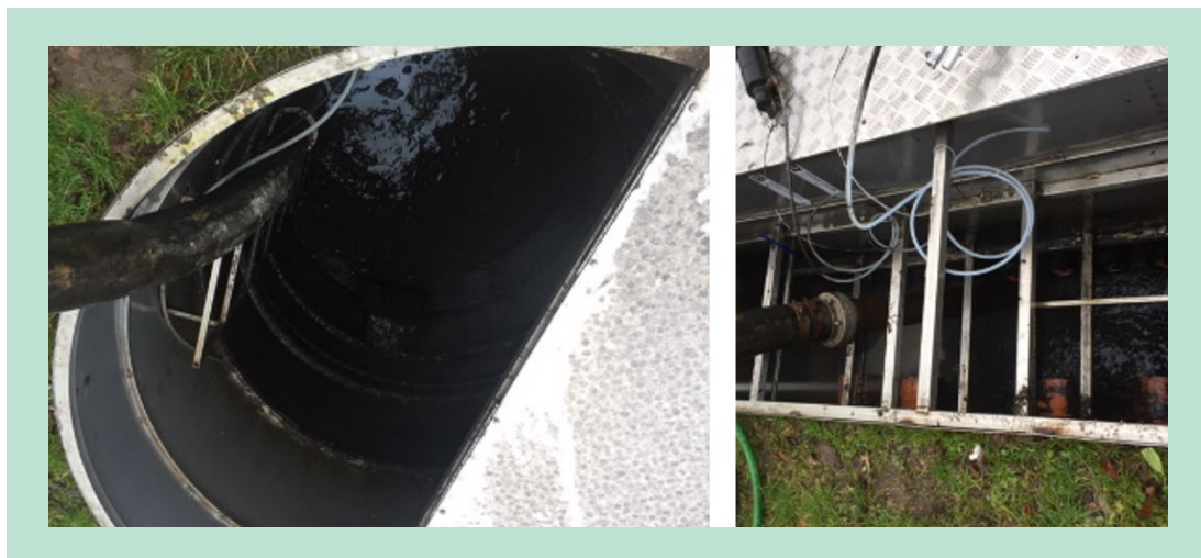
FIGUR 16. Oprensningen af indløbsbrønd og manifold foretaget i januar 2019.
