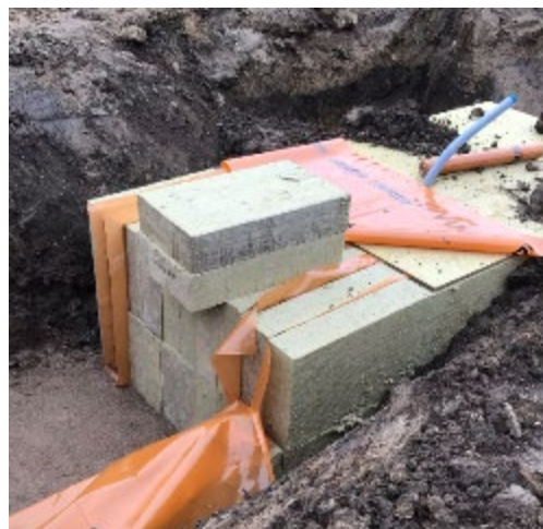
Stenuldselementer med afgangsrør (drænrør) forbundet med udløbsmanifold i bunden af filteret.
