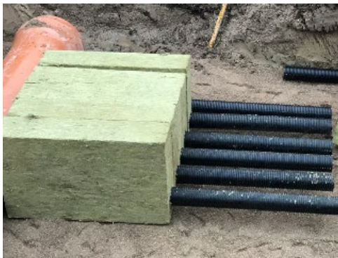
Stenuldselementer med afgangsrør (drænrør) forbundet med udløbsmanifold i bunden af filteret.
