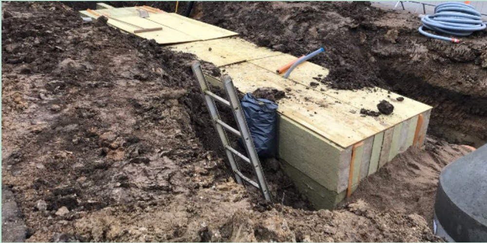
FIGUR 6. Stenuldselementerne, der udgør filterløsningen på Risvang Allé i Aarhus.
