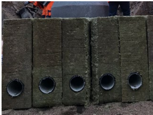
Stenuldselementer med afgangsrør (drænrør) forbundet med udløbsmanifold i bunden af filteret.
